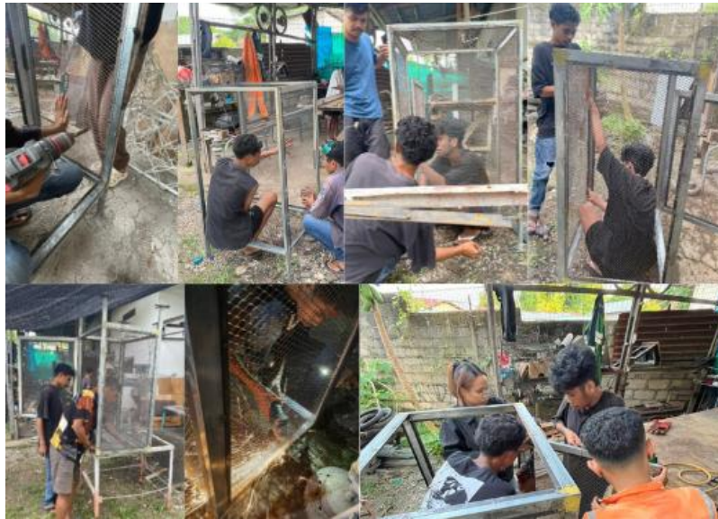
Gambar 6. Hari Ketiga dan Keempat (Proses Pemasangan Plat Bingkai Besi dan Jaring )
